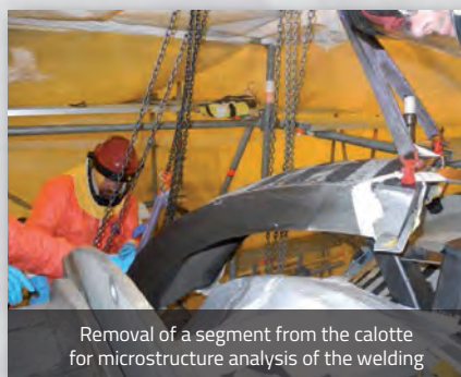
Cutting a pressure raiser for Vattenfall
